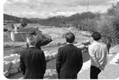
工事中の矢倉橋
