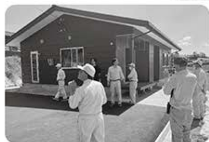
▲ 桑山地区移住定住促進住宅
