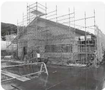
着々と建設が進む福祉施設
