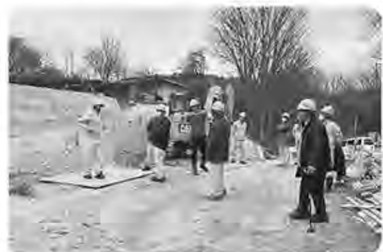
下井堀 道路拡幅工事
