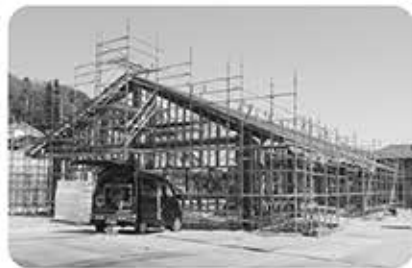
建設中の福祉施設
