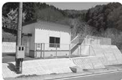
番場第一配水池が完成
