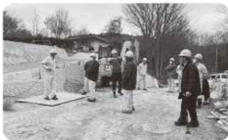
村道改良工事視察
