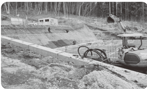
建設中の 北山水道施設 (3月10日視察)
