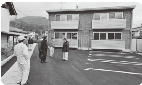
完成された明治町 地区集合住宅 (3月10日視察)
