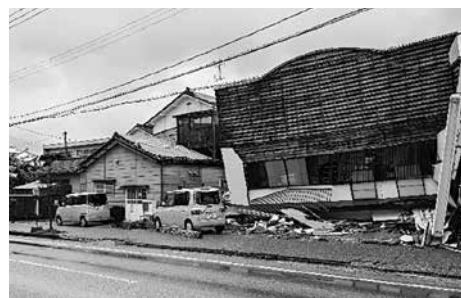
▲市内の古い本瓦葺きや高層の建物の多くが倒壊
