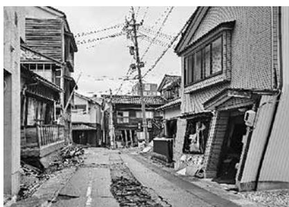
▲地震により道路は剥げ、傾いた電柱や建物
