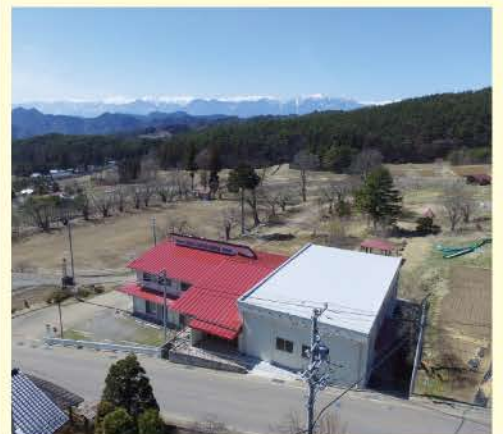
麻績村ゆりの木公園テレワークセンターの竣工
