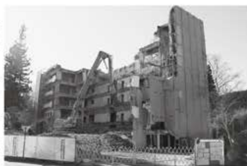
▲聖湖畔に建つ大型廃屋の解体撤去
