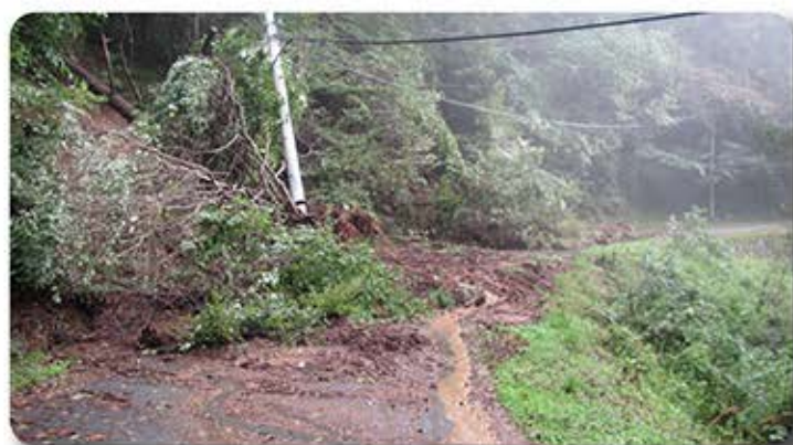
▲山腹崩壊で村道を塞ぐ(聖高原)
