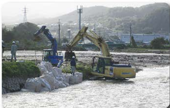
▲決壊した堤防の復旧作業 10/14
