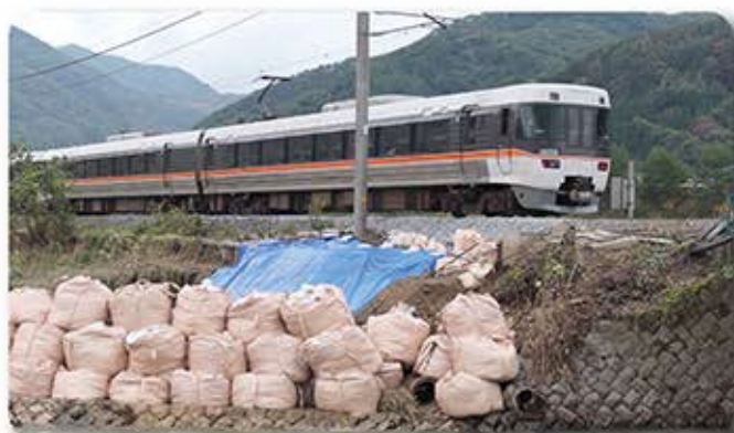
▲仮復旧した篠ノ井線(宮本地区)
