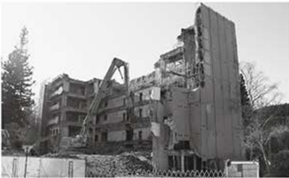
〔聖湖畔大型廃屋解体撤去〕 （聖地区）
