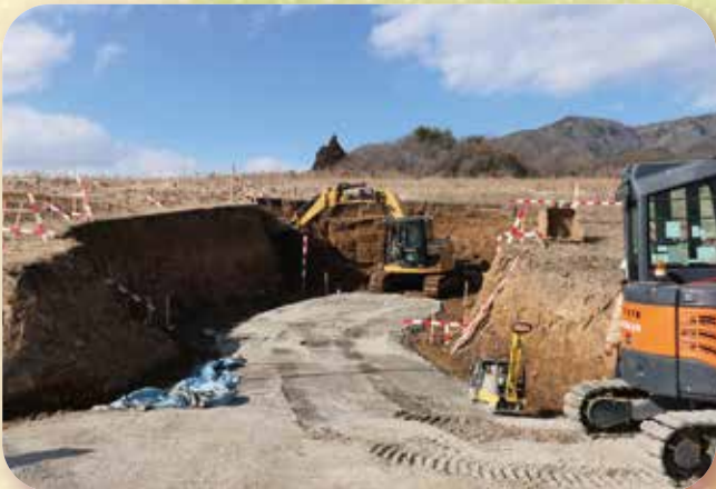
▲工事が進む小東地区定住促進住宅
