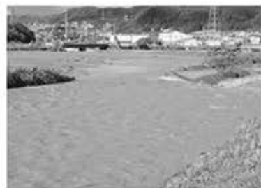
堤防が決壊した麻績川
