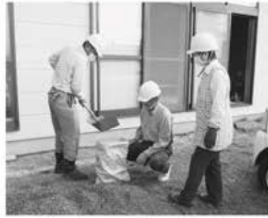
▲土のうの作り方を確認
