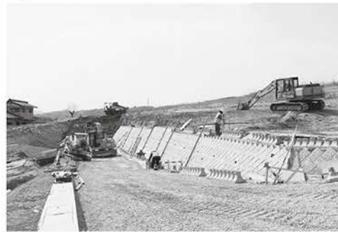
▲工事が進む小東地区造成住宅
