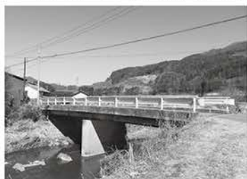
▲架け替え予定の矢倉橋
