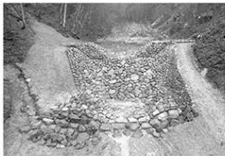
▲改修された石張りの堰堤
