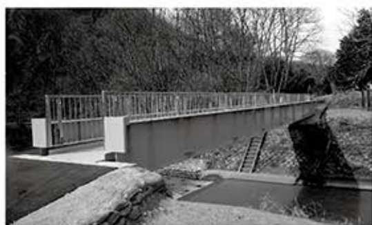
▲下田地区の橋梁
