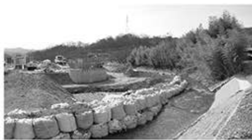
▲工事が進む矢倉橋
