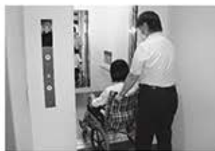
▲完成したエレベーター
