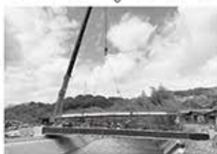
▲橋桁を架ける矢倉橋
