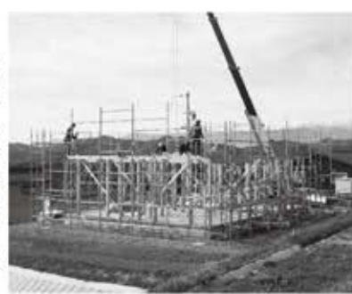
▲建設中の移住定住促進住宅
