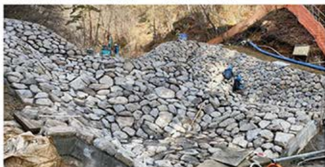
▲土石流に備えての砂防ダム 特殊工法で構築される芦澤川堰堤
