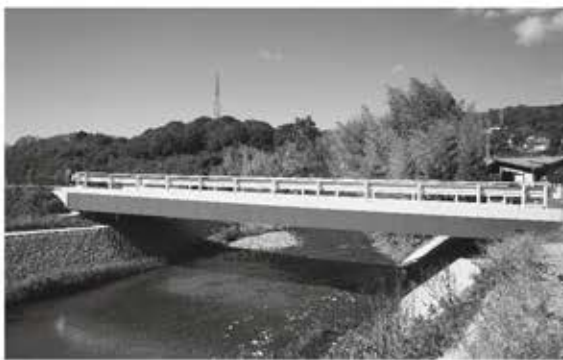
〔橋梁架替事業〕 (矢倉橋)
