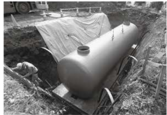
〔耐震性貯水槽整備事業〕 （上井堀地区）
