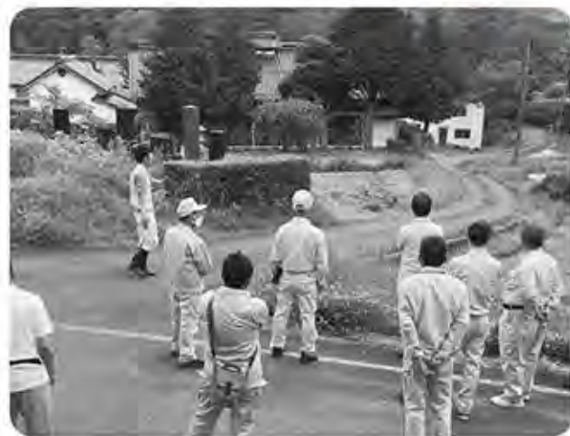
下井堀道路拡幅工事箇所
