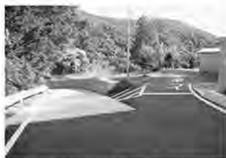
▲完成した下田の道路
