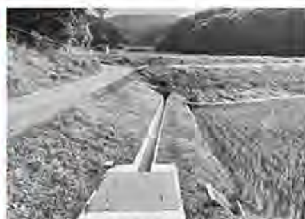
▲改修した市野川の水路
