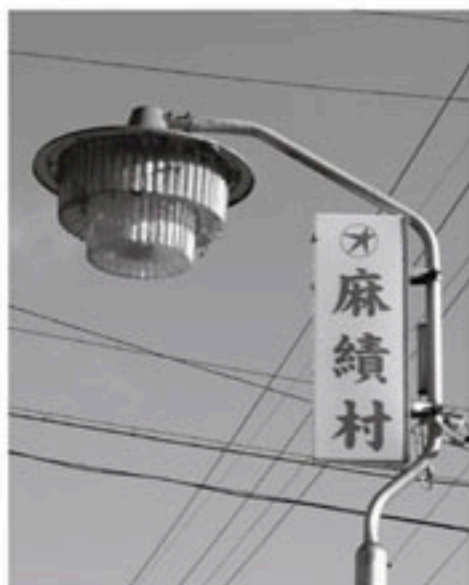
平成25年度改修工事が予定されている街路灯
