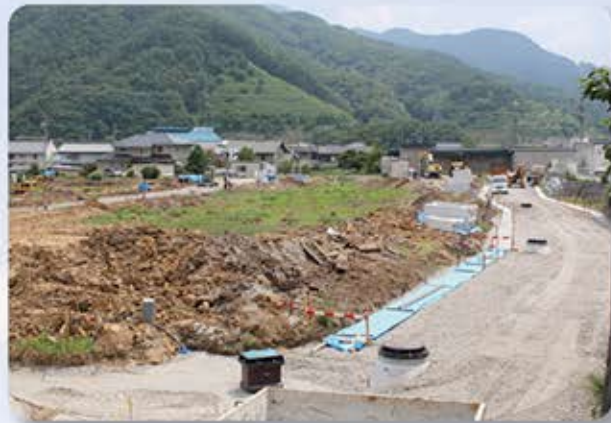
若者定住促進住宅建設地造成工事
