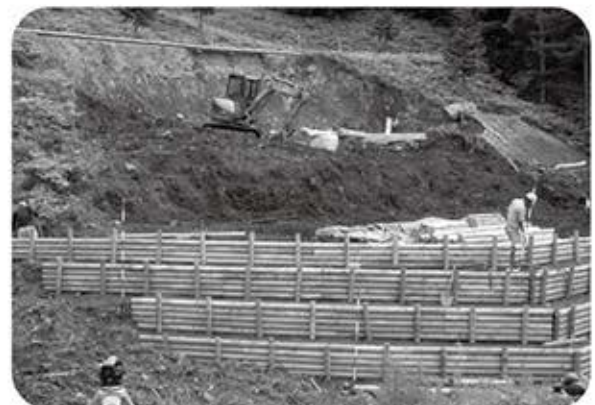
聖高原スカイライダー 法面崩落復旧工事(聖高原)
