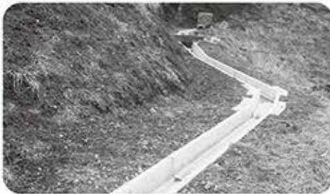
完成した用水路
