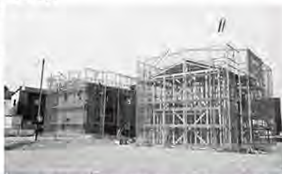
若者定住促進住宅は現在建設中です
