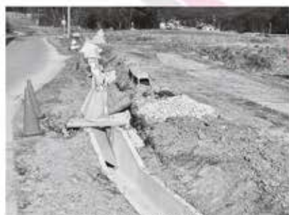
上井掘地区用水路改修工事
