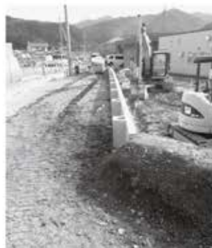
建設中の村道
