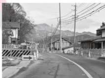
拡幅の進む国道403号
