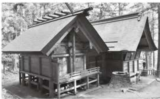
▲神明宮(完成した本殿と拝殿)
