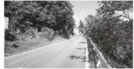
工事予定の国道403号
