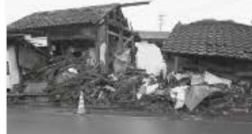
熊本地震で被災した建物
