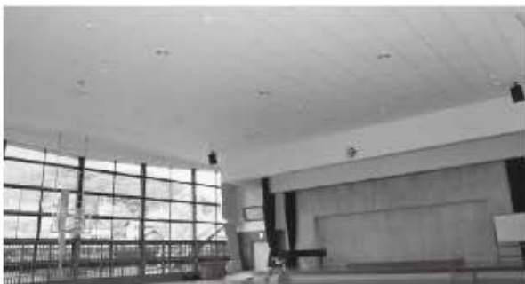
防災強化事業(小学校体育館天井改修)
