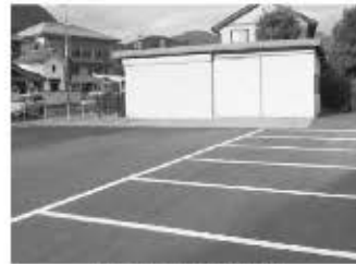
備蓄倉庫整備
