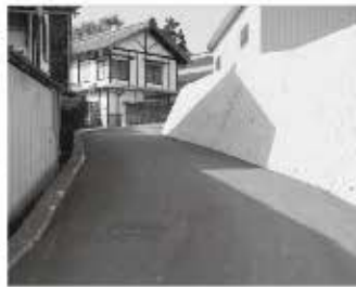
村道改良(下井堀地区)
