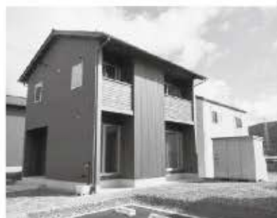
若者定住促進住宅は、年内竣工に向け工事中です
