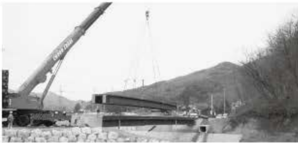
村道改良(野口橋架替)
