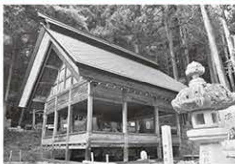
改修が進む神明宮
