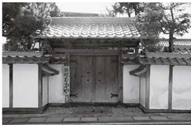
復元された看板がかかる正面入口
