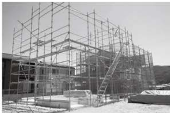
若者定住促進住宅は建設中です
