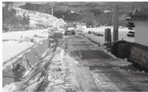
▲主要村道の改良整備(女淵地区)
