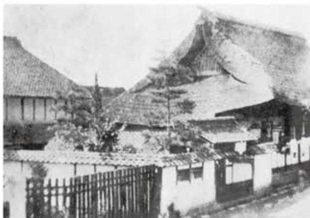
▲火災で焼け落ちた茅葺き入母屋造りの花屋母屋 (左側の建物が現存する東側別棟)
