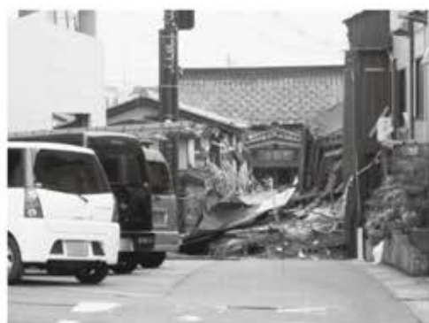
▲平成19年に発生した新潟県中越沖地震の際の建物倒壊現場
