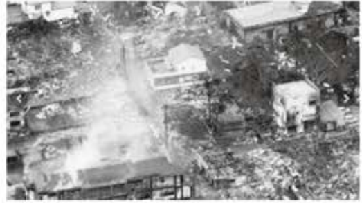
甚大な被害が発生した現場
