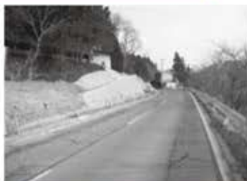
改良工事が進む国道403号
