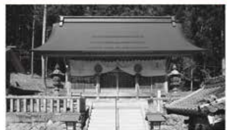
改修が終わった神明宮拝殿
