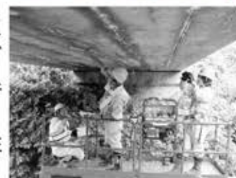
橋梁点検の作業風景
