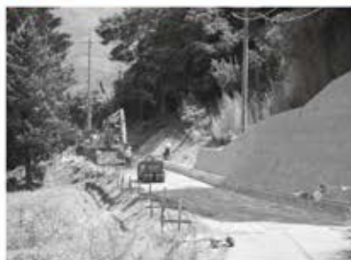
村道麻根9号線改良工事
