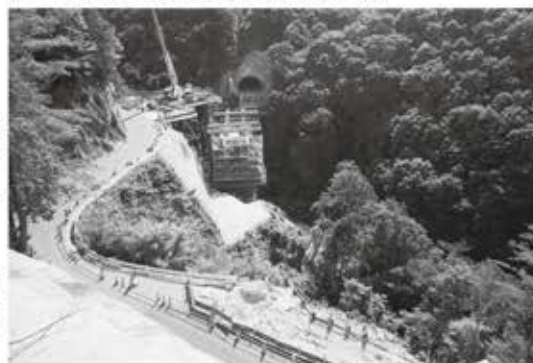
建設が進む滝上大橋
