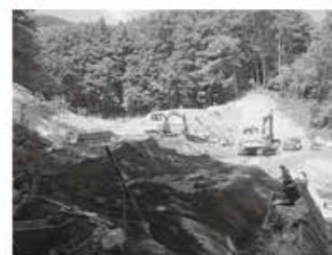
野田沢入池の改良工事
