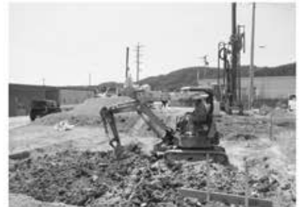
建設地の地盤改良工事
