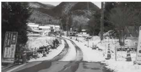
▲女淵区集落内村道
