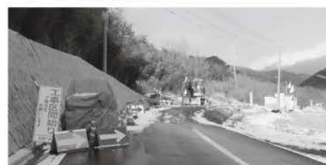
▲芦澤砂防事業工事用道路
