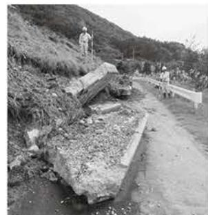
大雨による法面の崩壊
