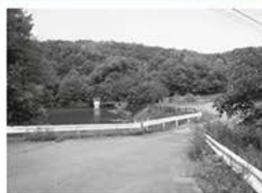
補強工事を実施する大沼池
