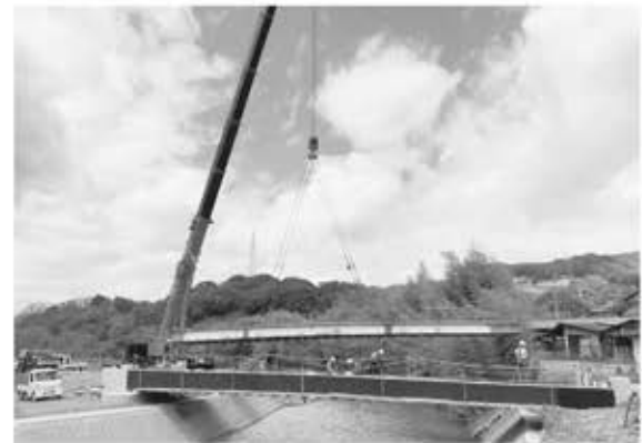
〔道路拡幅橋梁改修事業〕 （矢倉橋）
