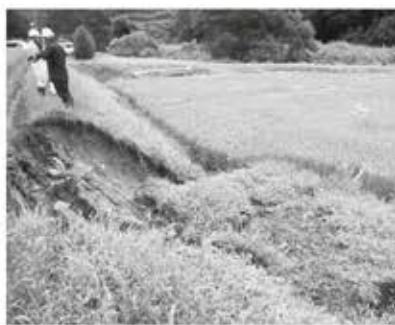
▲法面が崩落した水田(和合)
