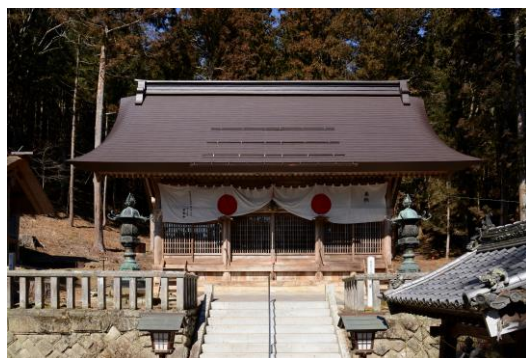
改修をした国指定重要文化財「麻績神明宮」
