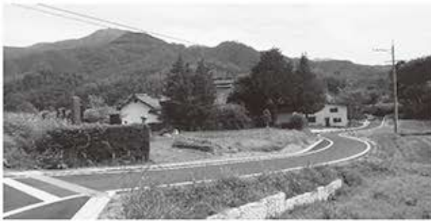
▲完成した下井堀の道路
