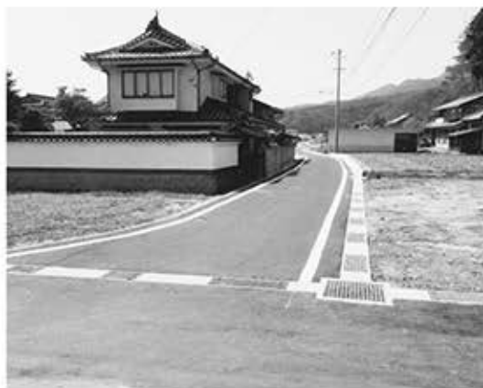
▲各地区で進む道路改良(宮本地区)
