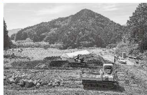
▲北山浄水場 建設予定地
