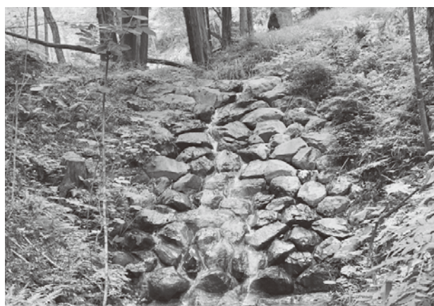
▲芦澤第一号石積堰堤
