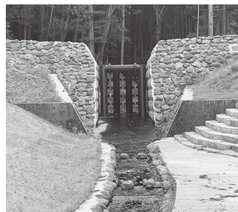
▲透過型の砂防堰堤
