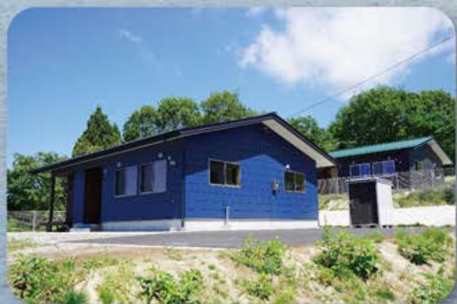
桑山移住定住促進住宅 完成
