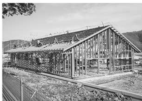
▲建設中の福祉施設
