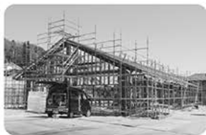
建設中の福祉施設
