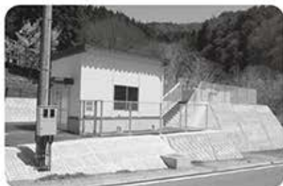
番場第一配水池が完成
